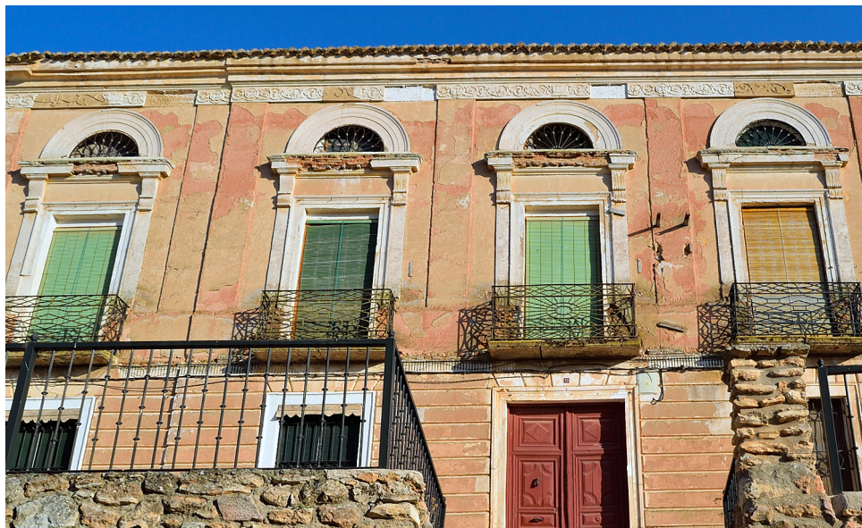
Fig. 3: Fachada principal de la Casa del Rey en la actualidad. Fuente: Foto del autor.
