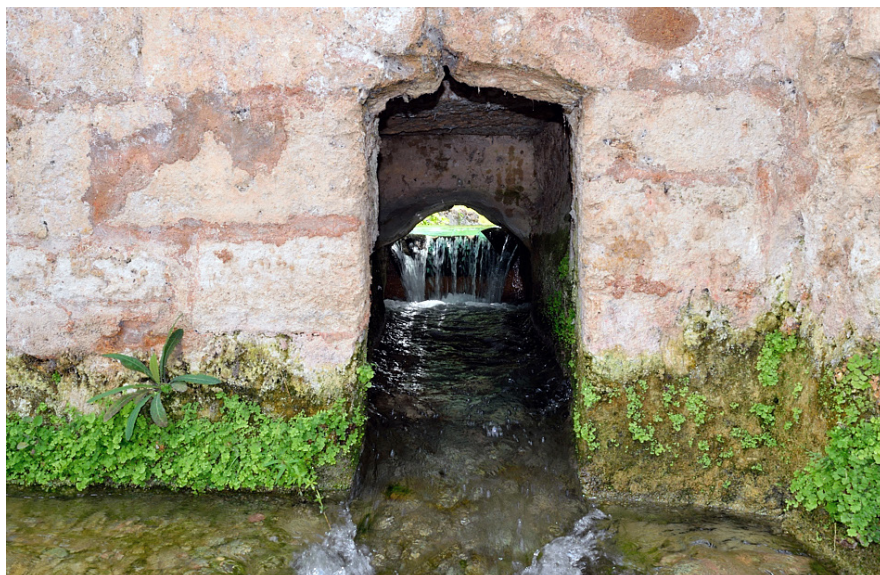
Fig. 10: Detalle de uno de los tres canales de la Compuerta Real de Ruidera en la actualidad. Fuente: Foto del autor.
