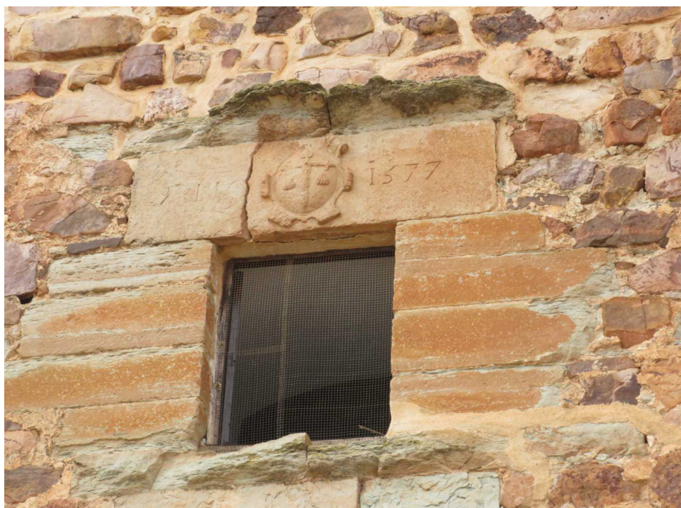
Fig. 3: Escudo y fecha en el lado sur de la torre. Fuente: Foto de Peñarroya García de Mateos.
