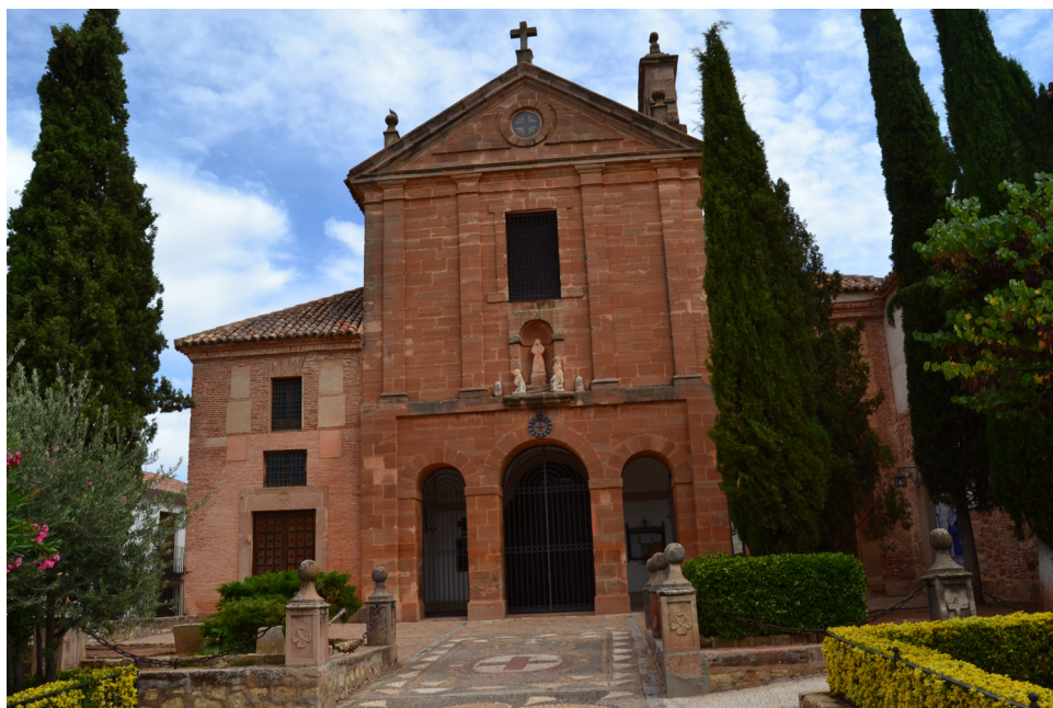
Fig. 11: Convento de los Trinitarios (Villanueva de los Infantes). Foto del autor.
