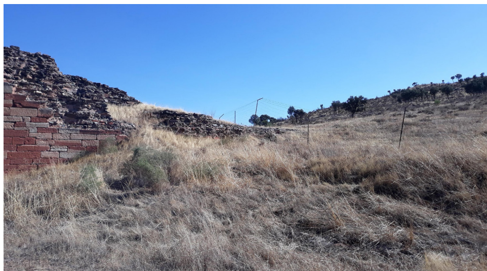
Fig. 14: Vallados de las fincas colindantes que impiden el paso al puente. Fotografía del autor.
