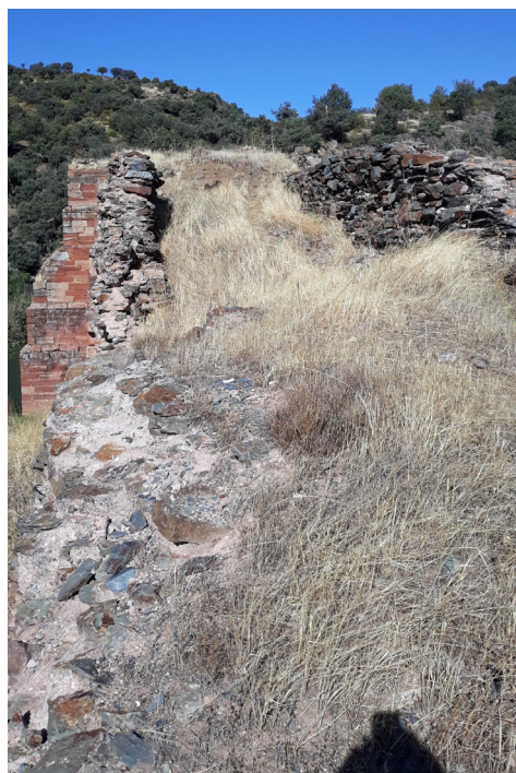
Fig. 12: Detalles del estado de conservación y posibles sillares retirados o detraídos del puente. Fotografías del autor.
