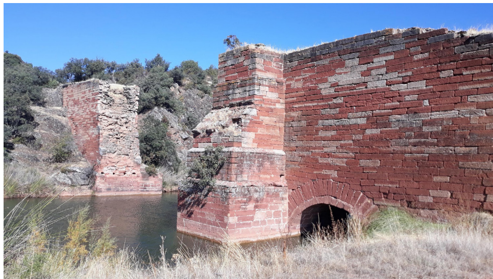
Fig. 7: Vista general del puente. Fotografía del autor.
