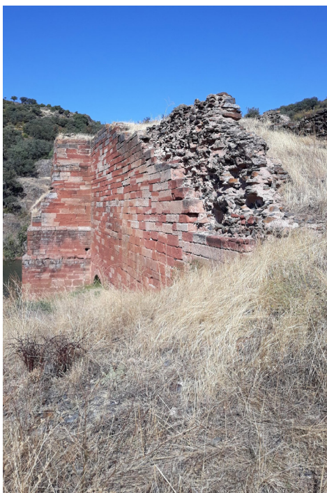
Fig. 12: Detalles del estado de conservación y posibles sillares retirados o detraídos del puente. Fotografías del autor.
