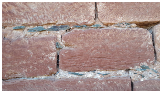
Fig. 6: (Izda.) Detalle de la técnica constructiva de los sillares del puente. (Dcha.) Sillares del puente con marcas de cantero. Fotografías del autor.
