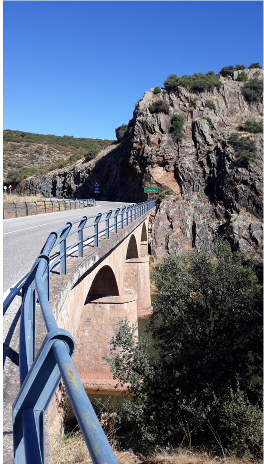
Fig. 22: Puente actual, cerca de antiguo en la CM-3127. Fotografía del autor.
