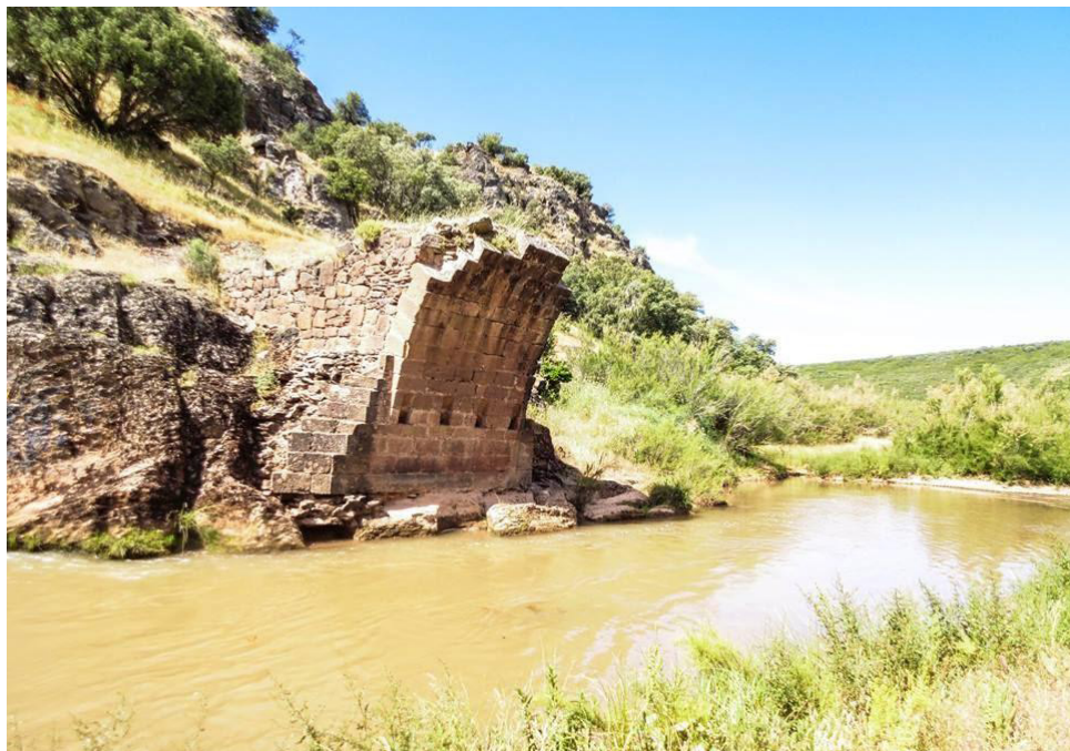
Fig. 19: Puente del antiguo Camino de Siles a Albaladejo. Fotografía del autor.
