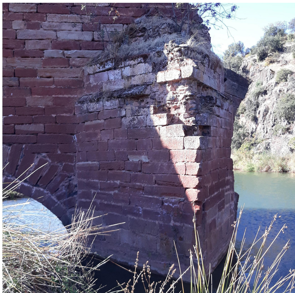
Fig. 5: Detalle del tajamar del puente. Fotografía del autor.
